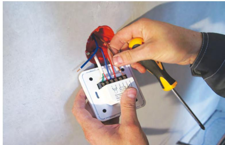
**15.** Устанавливаем в монтажную коробку терморегулятор и подключаем к нему теплый пол и датчик температуры пола. Подключаем терморегулятор к электросети и заземляем. Подключение необходимо производить по схемам, согласно инструкциям теплого пола и терморегулятора.
