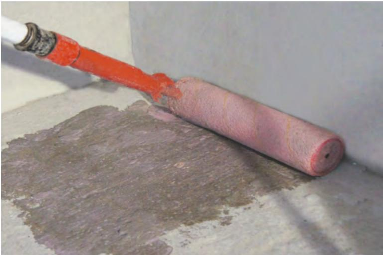
8. Подготовленную и очищенную поверхность пола рекомендуется покрыть грунтовкой глубокого проникновения. Дать поверхности высохнуть.
