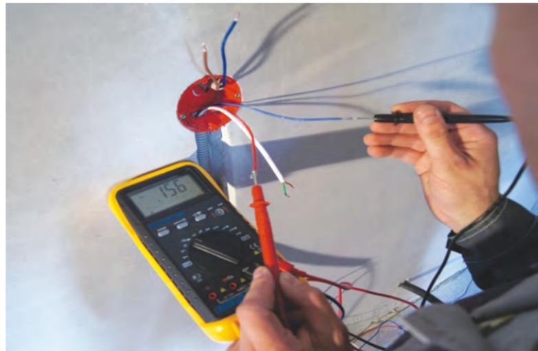
**13.** Снова проверяем нагревательный мат и датчик температуры на отсутствие повреждений, которые могли появиться в процессе заливки раствором, повторно измеряя их электрическое сопротивление.
