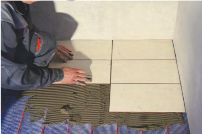
**14.** Наносим на просохшую поверхность пола новый слой плиточного клея и укладываем кафельную или керамическую плитку, керамогранит или другое покрытие. Время высыхания раствора указано в инструкции к применяемой плиточной смеси. Допускается укладка плитки сразу на нагревательный мат (см. Рекомендации, Заливка теплого, п.1). При этом необходимо проявлять максимум осторожности во избежание повреждения нагревательного мата.
