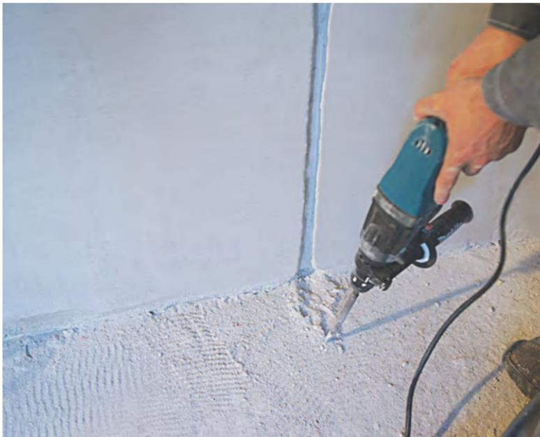
**4.** Диаметр гофра-трубки (16-20 мм) значительно больше диаметра нагревательного кабеля теплого пола **KOREASTAR Dymso**, поэтому ее необходимо заглубить в пол, так что бы она не выпирала выше уровня, уложенного нагревательного мата.
