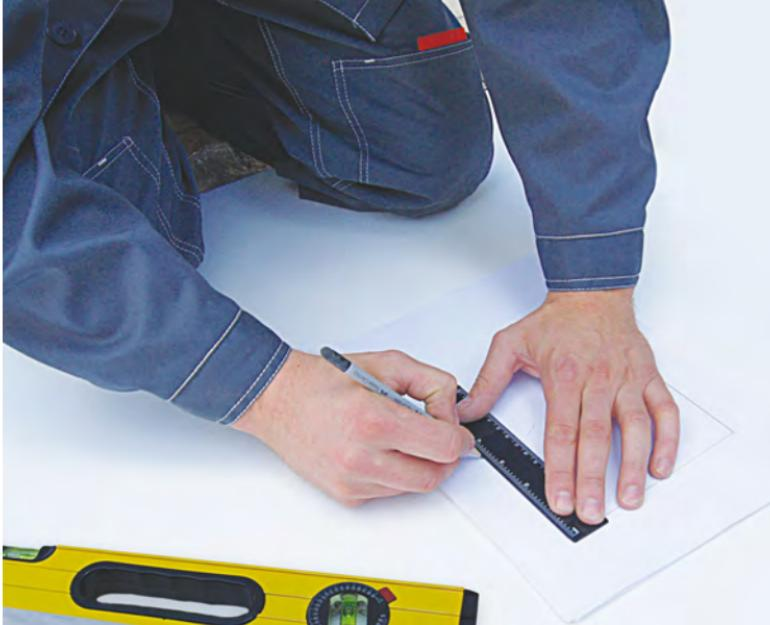
**2.** Составляем чертеж обогреваемой площади, с указанием расположения нагревательных матов, датчика температуры и места подключения к электросети. При возможном повреждении греющего кабеля в процессе укладки тёплого пола или в процессе строительных работ, чертеж значительно облегчит вам поиск места повреждения.
