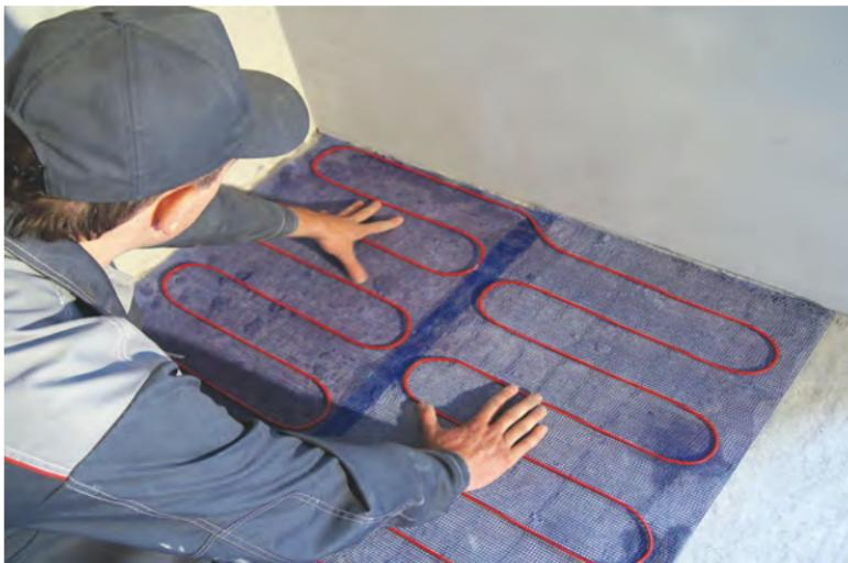
**10.** Фиксируем нагревательный мат на поверхности пола. Сетку мата можно зафиксировать на поверхности пола с помощью самоклеящейся ленты, kleящего пистолета, гвоздей, скоб и т.д. Нагревательные маты не требуют жесткого крепления к полу.
