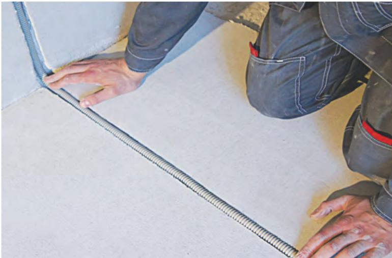
**6.** Помещаем датчик температуры в гофра-трубку, укладываем ее в штробу и выводим к терморегулятору. Конец гофра-трубки, оканчивающейся в полу, необходимо надежно заглушить для предотвращения попадания внутрь гофра-трубы цементно-песчаного или клеевого раствора. Радиус изгиба трубы «поп-стена» должен быть не менее 5 см.
