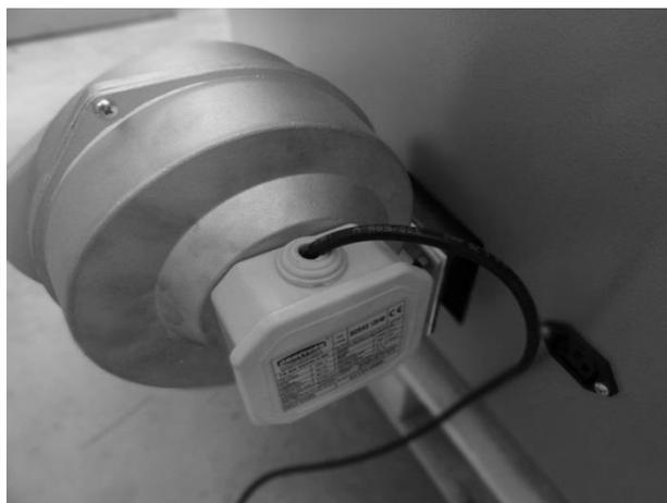
**Внимание:** Правильная установка вентилятора очень важна, так как его воздушная заслонка расположена внутри котла. Четко следуйте инструкциям по установке вентилятора. Вентилятор имеет еще одну заслонку на входной части для ограничения попадания воздуха внутрь вентилятора. Вы можете использовать эту заслонку для контроля потока воздуха во время сжигания топлива.
